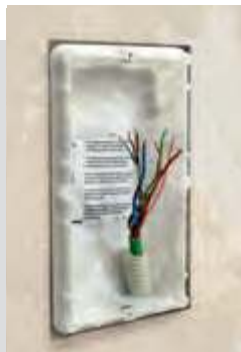
Izmjena starog ulaznog panela
