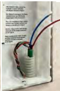
Korištenje postojeće instalacije za novi ulazni panel
